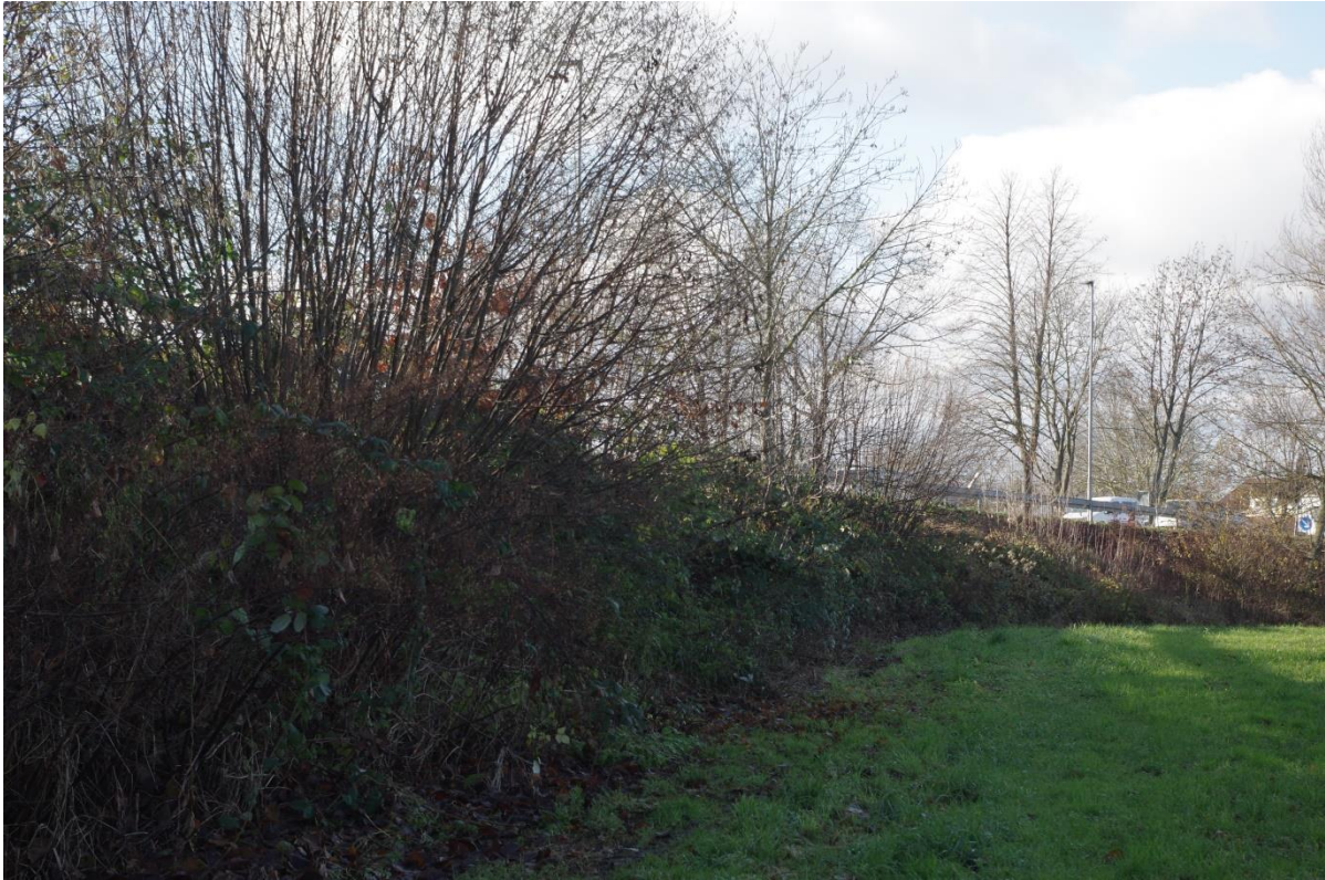
Abb. 7: Böschungsbereich an der Hauptstraße
